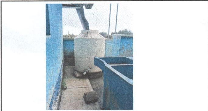
Foto 7: Sustitución de depósito de agua 1700 litros.
